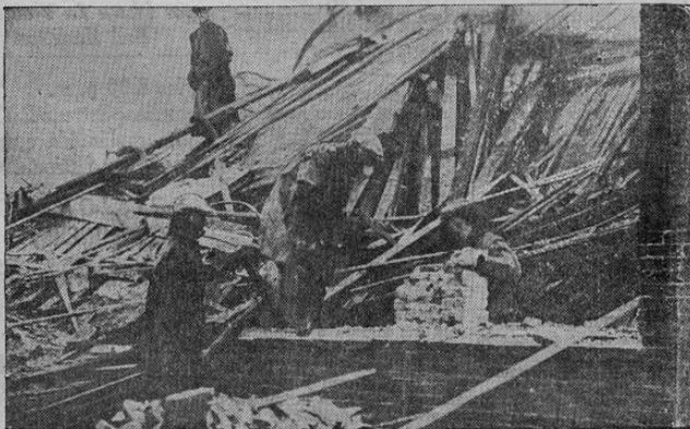
Este edificio de tres pisos de Reading, Pensylvania, fué destruido por una explosión, causando la muerte de dos transeuntes
